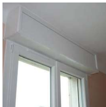
Pose des joues et joints d'étanchéité
