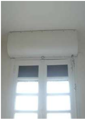
Volet roulant et fenêtre avant rénovation
