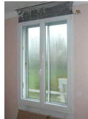
Pose de la nouvelle fenêtre PVC
