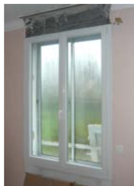
Pose de la nouvelle fenêtre PVC
