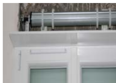
Pose de la sous-face
