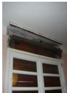
Dépose du coffre bois et du tablier de volet existant
