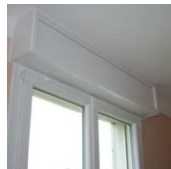
Pose des joues et joints d'étanchéité
