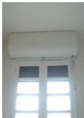
Volet roulant et fenêtre avant rénovation
