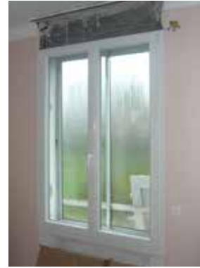
Pose de la nouvelle fenêtre PVC
