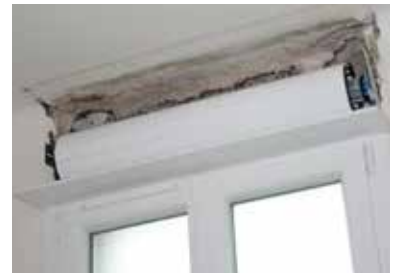
Pose et réglage du tablier de volet roulant
