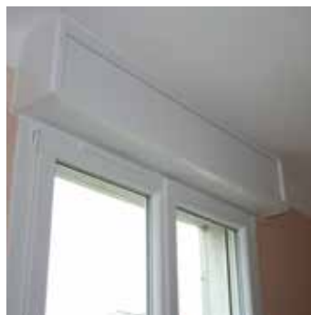
Pose des joues et joints d'étanchéité
