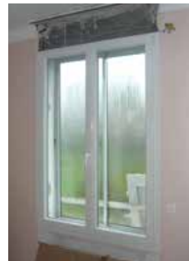
Pose de la nouvelle fenêtre PVC
