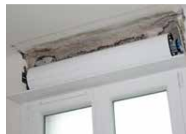
Pose et réglage du tablier de volet roulant
