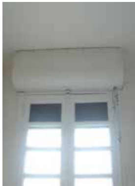
Volet roulant et fenêtre avant rénovation
