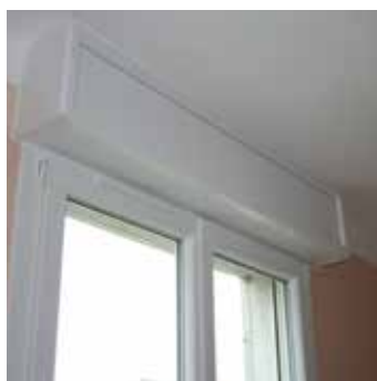
Pose des joues et joints d'étanchéité
