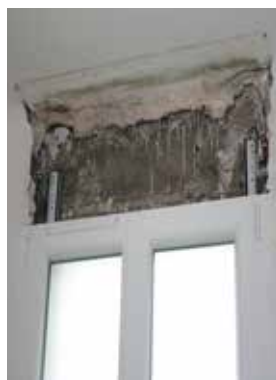
Mise en place des glissières du volet roulant
