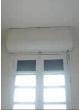
Volet roulant et fenêtre avant rénovation.
