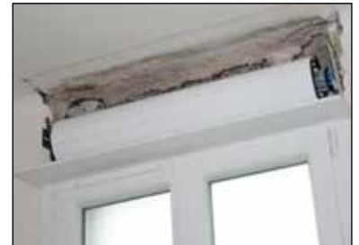
Pose et réglage du tablier de volet roulant
