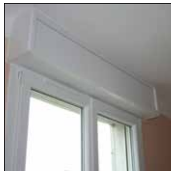
Pose des joues et joints d'étanchéité
