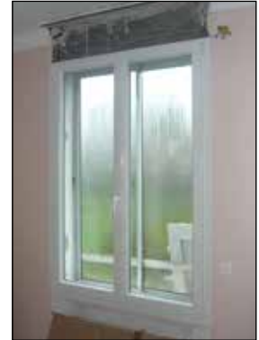
Pose de la nouvelle fenêtre PVC
