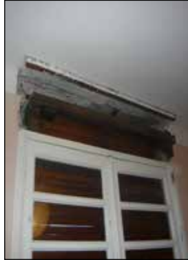
Dépose du coffre bois et du tablier de volet existant
